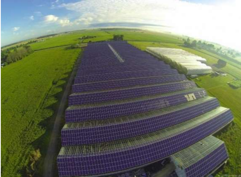
SLIKA 11 - SOLARNE ELEKTRANE - PRIMJER
